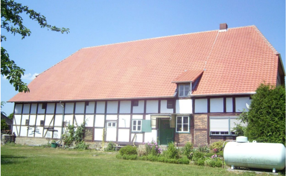
Die Gartenseite des Niedersachsenhauses nach der Sanierung
